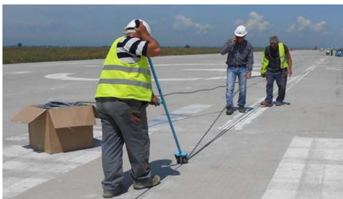
Obrázek 1: Aplikace výplňového provazce válečkem
