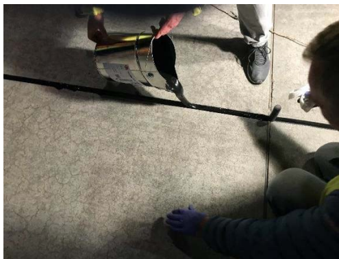
Obrázek 3: Aplikace tmelu Sikaflex-406 KC přímo z kovové nádoby
