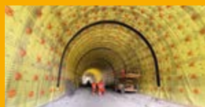
HYDROIZOLACE SPODNÍ STAVBY
