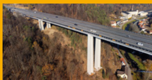
SANACE A OCHRANA KONSTRUKCÍ
