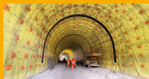
HYDROIZOLACE SPODNÍ STAVBY
