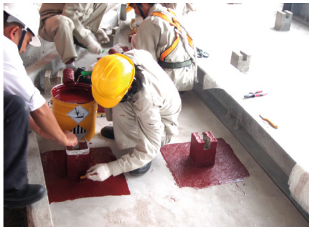
2. ZPRACOVÁNÍ DETAILŮ - ZÁKLADNÍ NÁTĚR A VLOŽENÍ VÝZTUŽNÉ ROHOŽE
