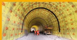
HYDROIZOLACE SPODNÍ STAVBY
