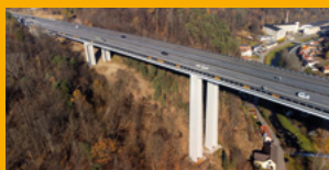
SANACE A OCHRANA KONSTRUKCÍ
